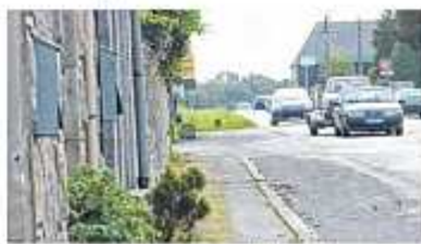
A Trégon, les voitures passent tout près des façades.
