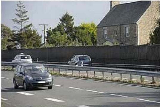
Mur anti-bruit sur l'axe Guingamp-Lannion au niveau de la section Ribault-Canvaux. Photo: Thierry Jeandot
