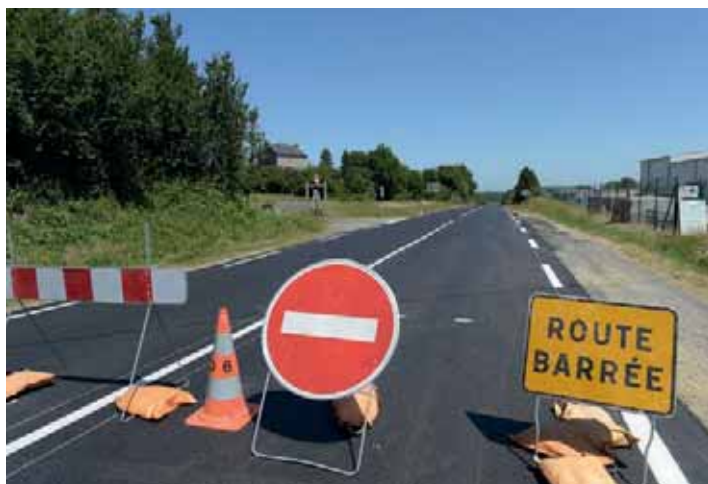
◀ Chantier de rénovation routière sur la RD11 - Beg ar C'hra - par un enrobé de plus de 2,5 kilomètres sur le territoire des communes de Plounévez-Moëdec, Plouaret et Lanvellec, en mai 2020. Coût des opérations: 295 000 euros.
