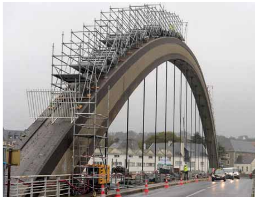
◀ Le Pont Canada, à Tréguier, qui a bénéficié de travaux de réfection d'ampleur en 2019.
