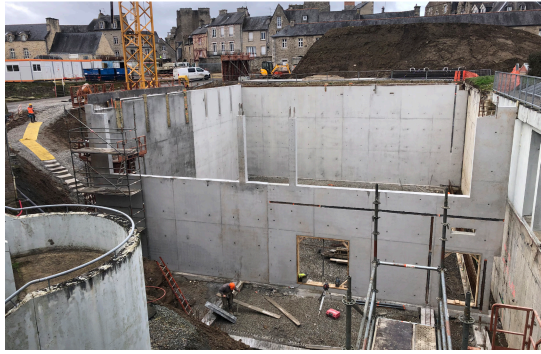
Le chantier de reconstruction début 2024
