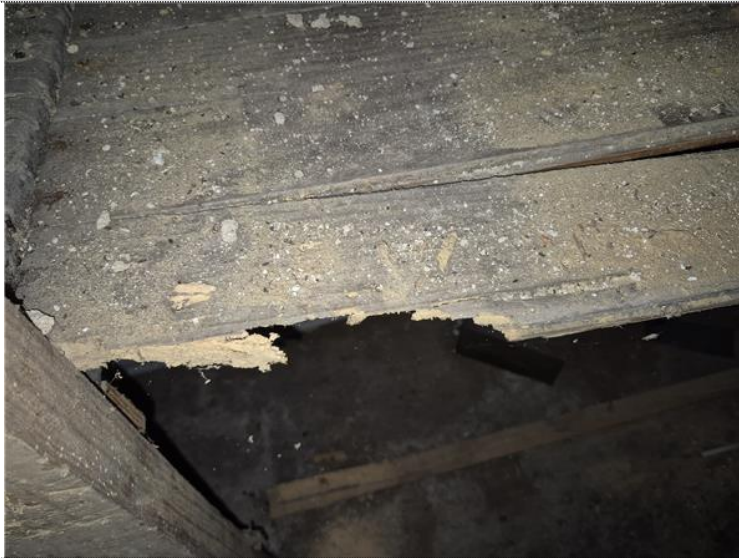
Cave B sous escalier(R-1) : Etagère fixe (Bois)
