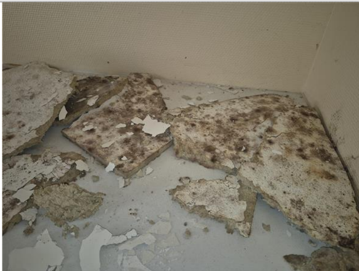
Sanitaires-caféteria(RDC) : Plafond (Dalle de faux-plafond)
