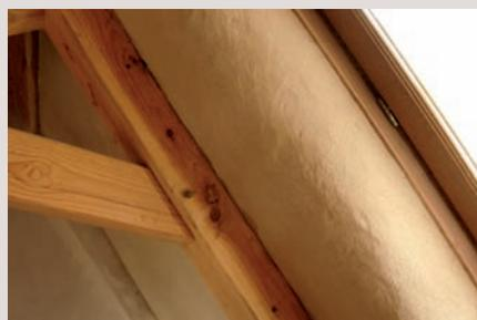
Côté sud, les combles ne sont pas isolés. La chaleur accumulée par les ardoises est ventilée sous la dalle.
