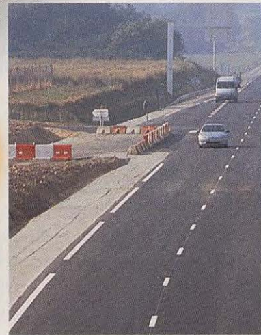
Axe Guingamp-Lannion-Perros-Guirec : après l'ouverture en 1999 de la déviation de Bégard (photo ci-dessus), démarrage dans quelques semaines du chantier de la déviation est de Lannion.
