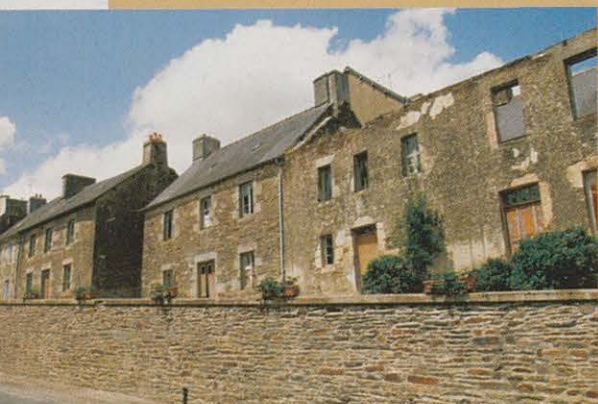
Futur atelier-musée d'Uzel : ancienne manufacture Léauté-Planeix avec les maisons de tisserands mises à disposition des "toileux".
