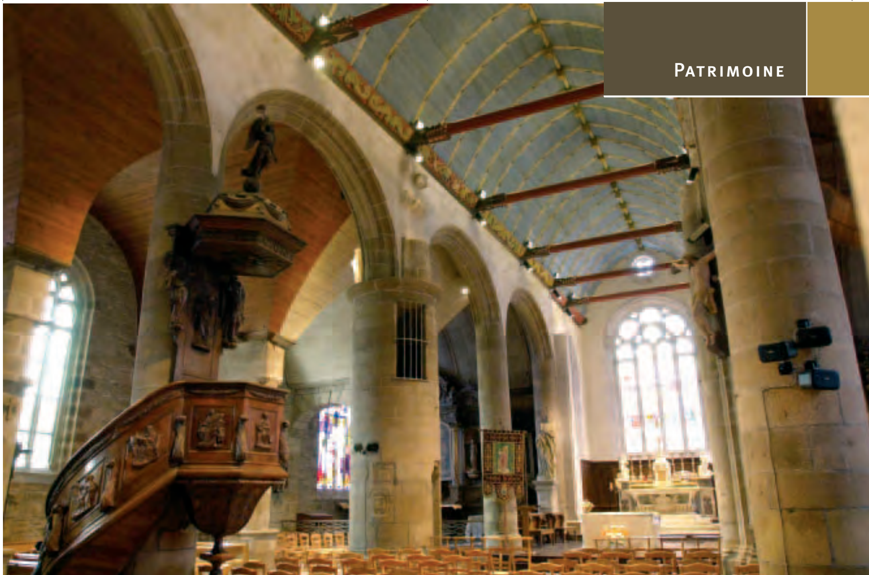
Église Saint-Jean-du-Baly, à Lannion, a rouvert ses portes après deux ans de travaux
