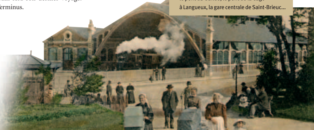
La gare de Saint-Brieuc, en 1853
