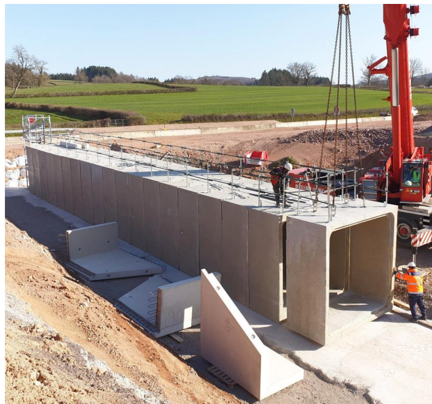
Exemple d'ouvrage cadre préfabriqué
