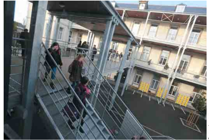
Le collège Anatole-Le-Braz a été entièrement rénové par le Département.
