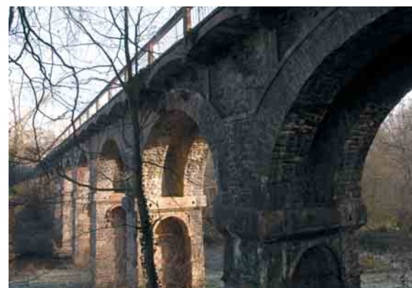
Le viaduc de Blanchardeau.
