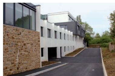
La Maison du département.
