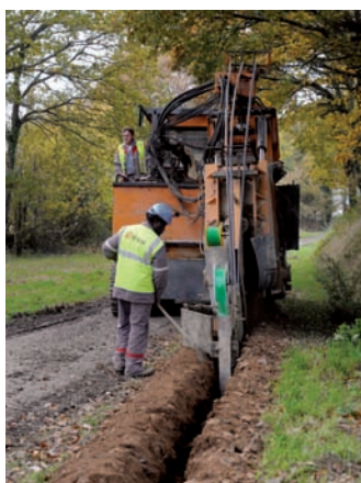
La mise en place du câble pour le haut débit, le long de la VFIL.
