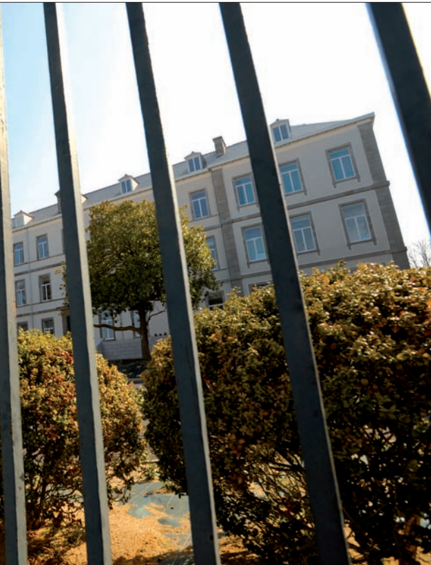
La façade rénovée du collège.
