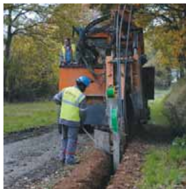
Une tranchée est effectuée afin d'enfouir la fibre optique.
