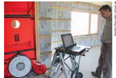
L'utilisation d'une porte soufflante permet de mettre le bâtiment en pression ou dépression, de manière à déceler les entrées d'air parasites.
