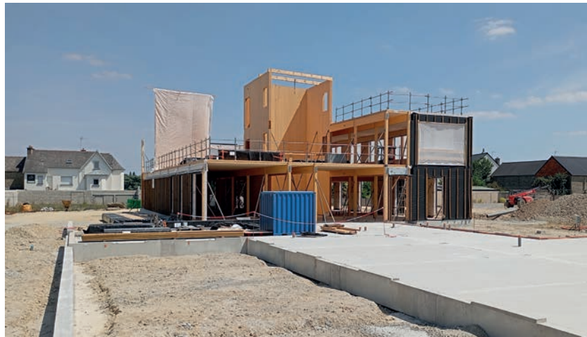
Juillet 2026. Poteaux, poutres et planchers en bois sont progressivement mis en œuvre. Au centre, la cage d'ascenseur s'élève.
